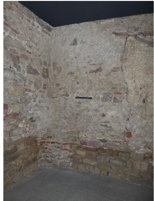
4: Reparatur der Burkhardtschen Stadtmauer von ca. 1358
