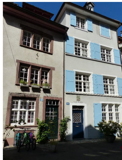
4: Wohngebäude in der Altstadt um ca. 1300 und teilweise früher
